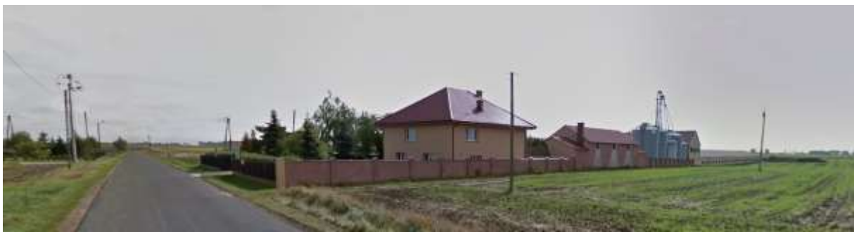
Zabudowania przy zakładzie usługowym Rolnit.ZPU
