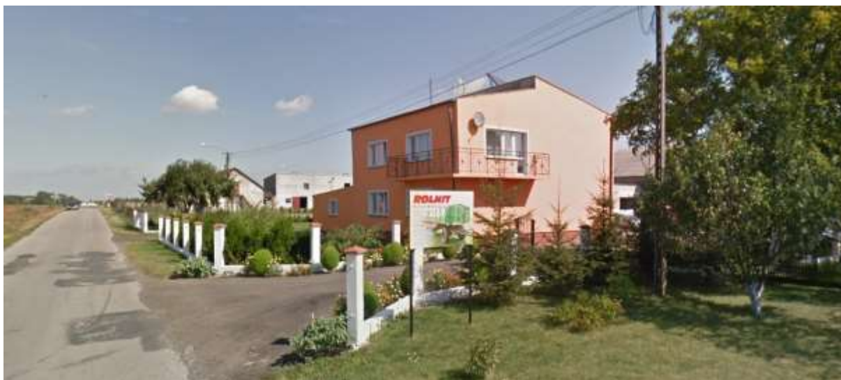
ROLNIT ZPU – przy drodze gminnej
