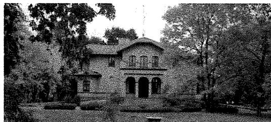
Fotografia 11. Widok na Dwór w Orłowie.
