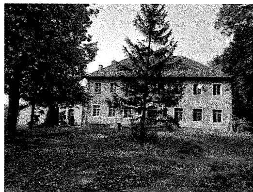
Fotografia 10. Widok na pałac w Marulewach.
