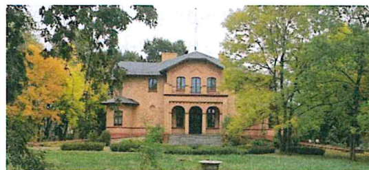
Fotografia 11. Widok na Dwór w Orłowie.
