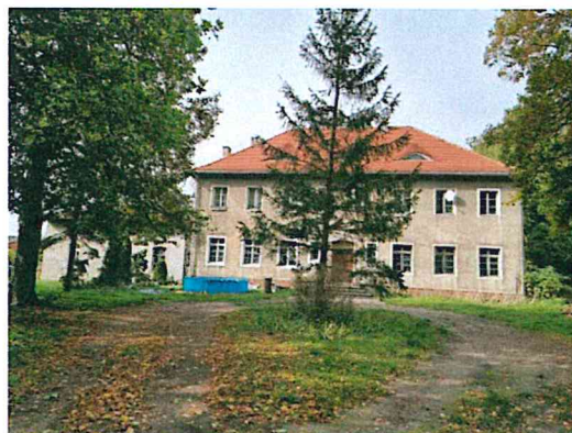
Fotografia 10. Widok na pałac w Marulewach.
