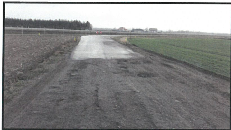
Miejsce włączenia przebudowywanej drogi do drogi serwisowej Obwodnicy miasta Inowrocławia
