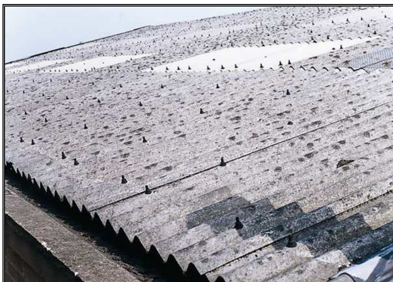
Rysunek 1. Dach pokryty azbestową płytą falistą
