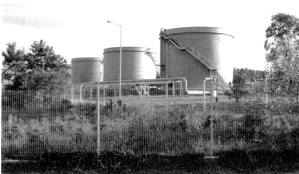
Instalacje kopalni soli
