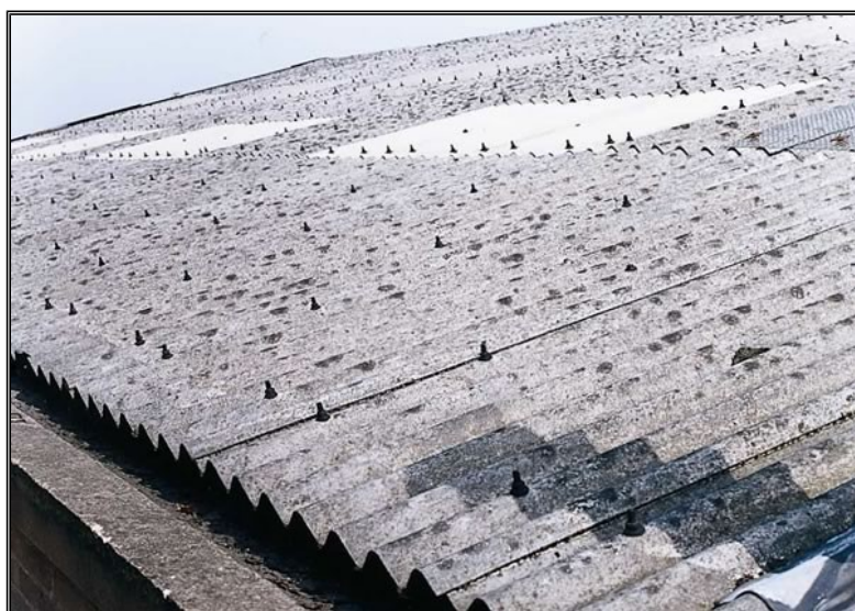
Rysunek 1. Dach pokryty azbestową płytą falistą
