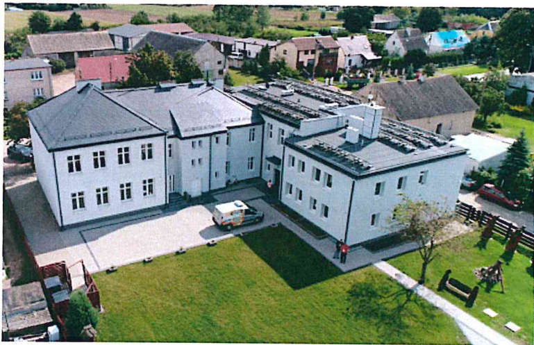
Budynek komunalny w Łojewie, źródło - materiały własne UG Inowrocław.
